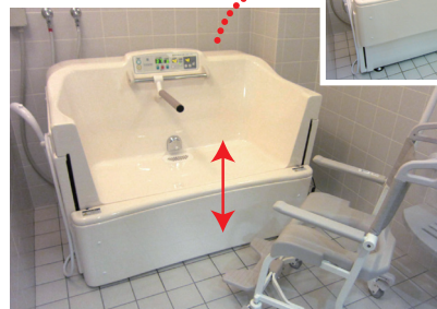
浴槽(個浴に近い快適浴槽)
