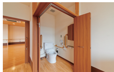
居室(出入りが楽! 2面開閉できる高性能な扉)
